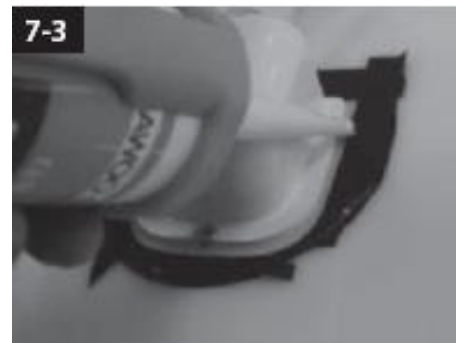
7-3 Aplikujte silikon na okraj držáku (včetně šroubů)
