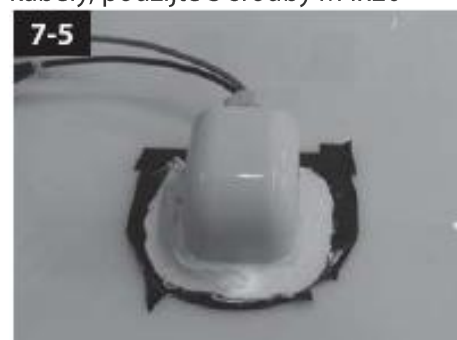
7-5 Odstraňte přebytečný silikon
